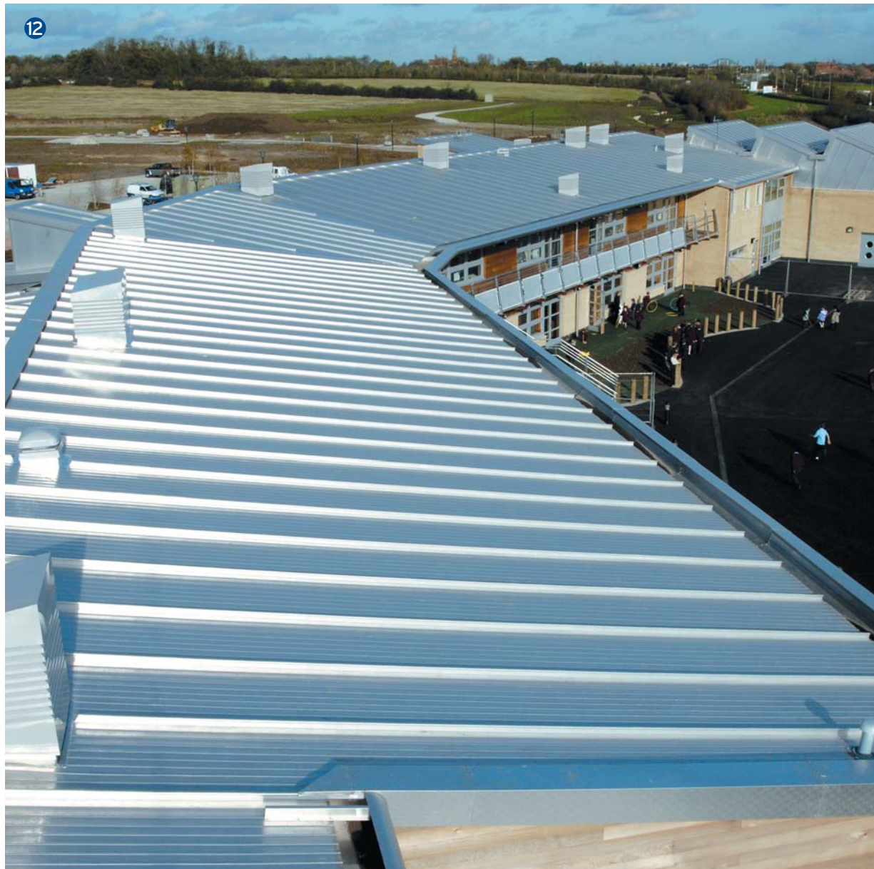
12 Oxley Park School met Kingzip® geïsoleerde dakpanelen
